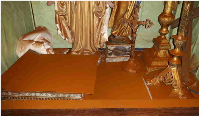
Intense sporée de couleur rouille, dans le placard d'une église, portes fermées...
