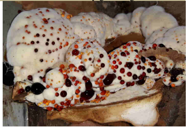
Larmes de polypore ( Donkioporia expansa ) sur une solive.
